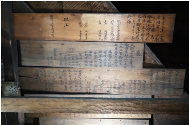
図6 野屋根に残る棟札類 (一部)
