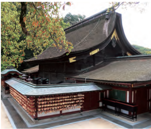
図2 御本殿（北西側面）
